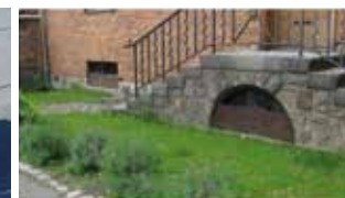
(TI) Vinduer tæt på terræn kan sikres med en permanent skot
